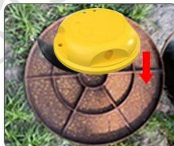
第二步：打开井盖，将组装完成的设备固定在井盖横梁或加强筋上
